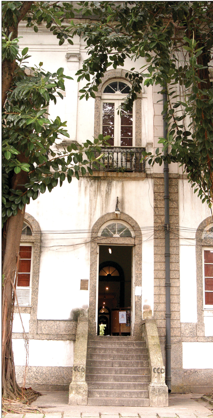
A ECO funciona em prédio tombado na Praia Vermelha
