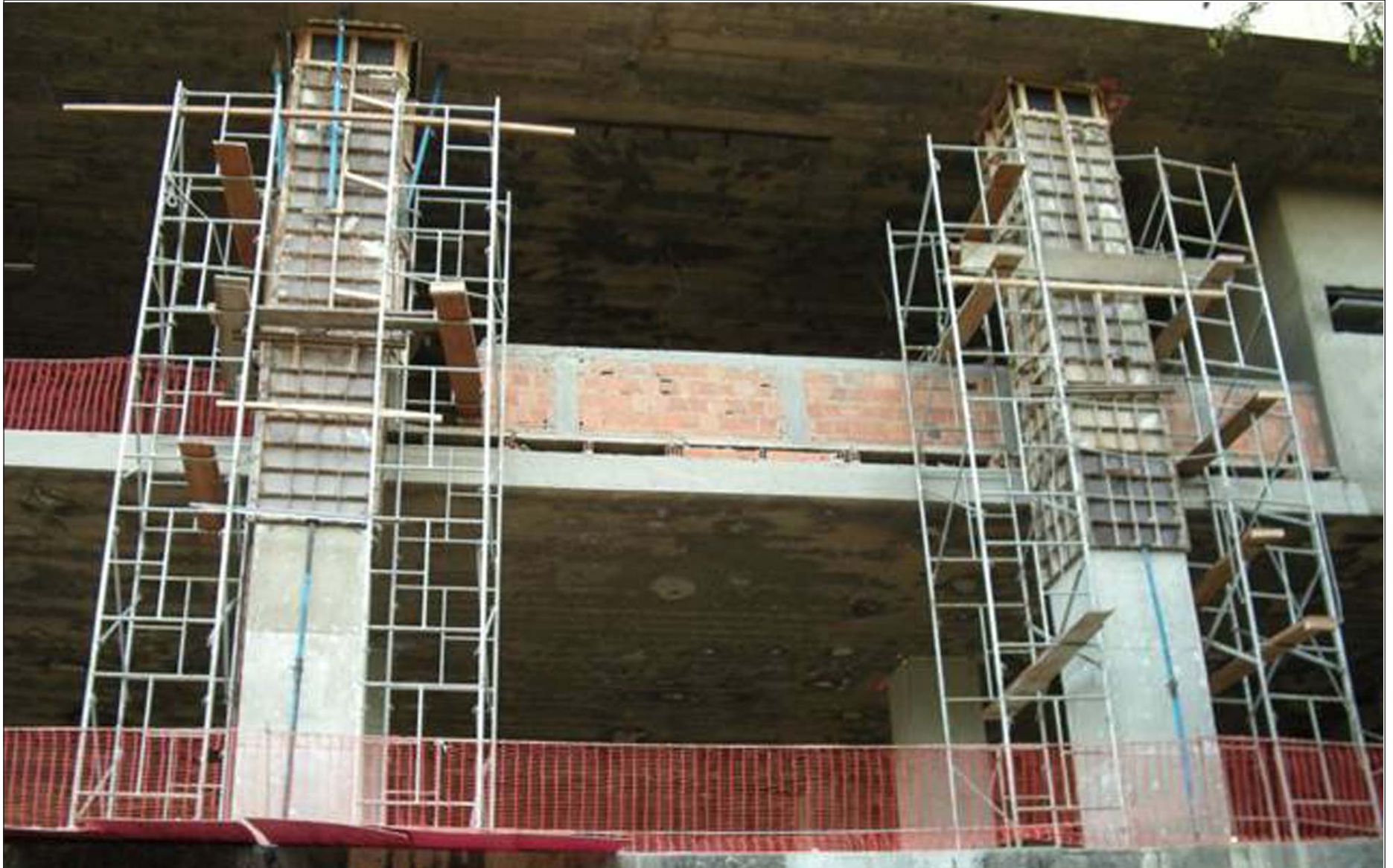
REFORÇO nas pilastras libera o bloco D às atividades normais no HU
