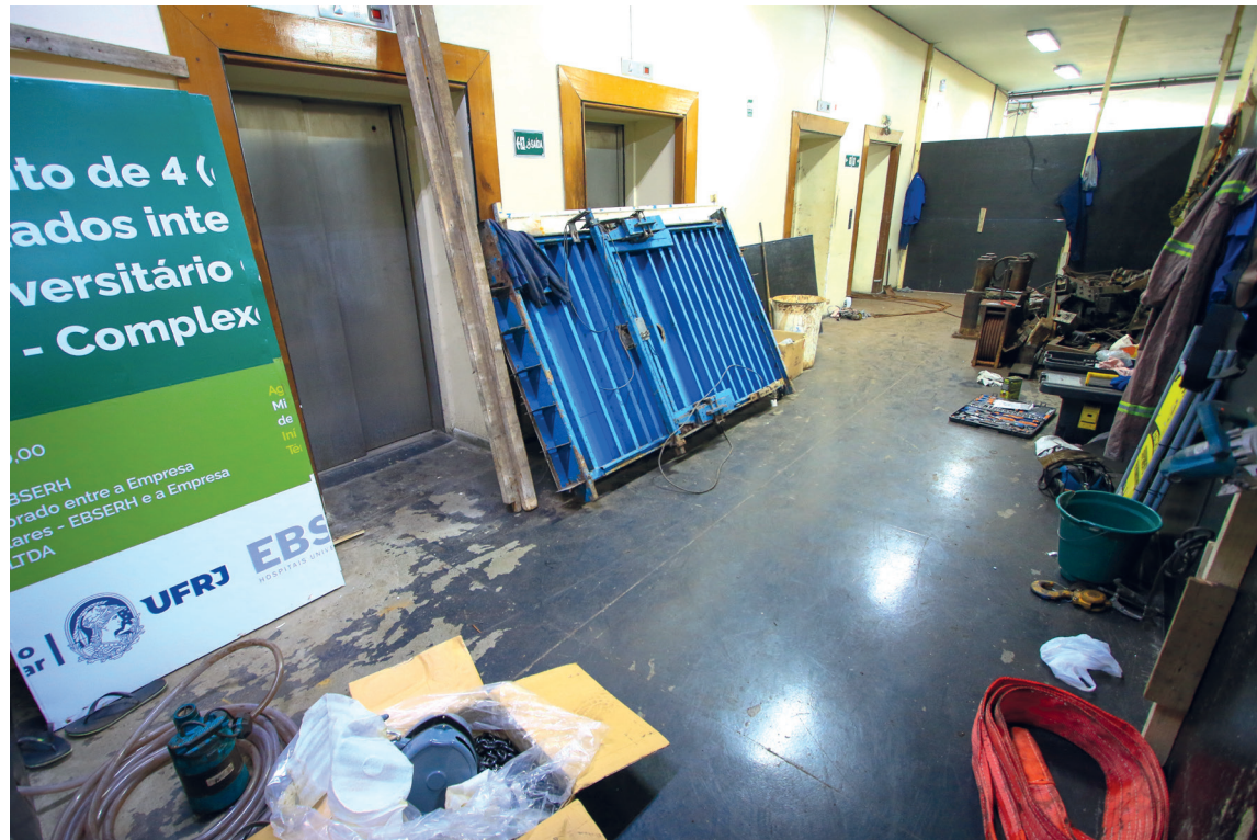
HALL DOS ELEVADORES em recuperação mecânica no HU: barulho da queda assustou servidores
